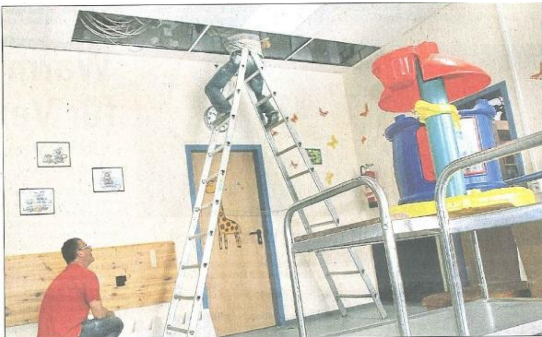
Voller Körpereinsatz beim Umbau der „Rappelkiste“: Da kriechen Handwerker auch schon mal in die Decke. • Foto: Pelka
